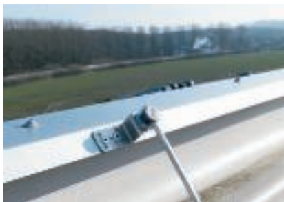
Aansluiting van de metalen dakrand op het bliksembeveiligingssysteem
