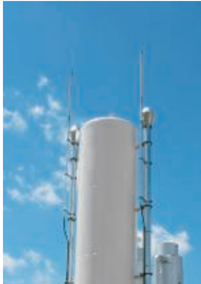
isCon®-systeem in de schoorsteen van een biogasinstallatie
