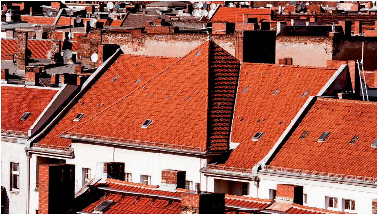
Brandwanden verhinderen een brandverspreiding
