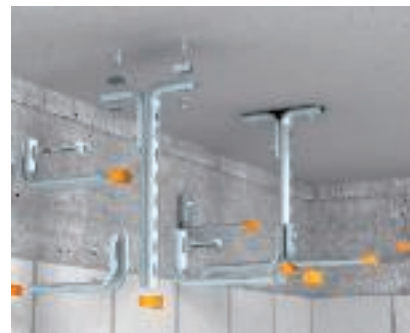
Afgewerkte installatie van een TP-systeem Montage van het TP-hangprofiel met kopversterking en tweezijdige consolemontage alsmede directe montage aan de wand.
