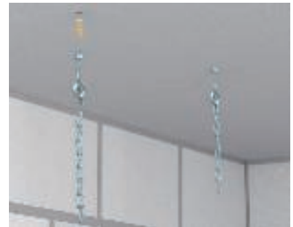
Kettingophanging Realisatie van een kettingophanging voor armatuurdraagsystemen met ankers, plafondhaken type 948/TG6 en ophangketting type LTK-K.
