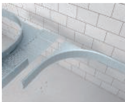
Maken van een T-aftakking met hoekaanbouwstuk Montage van het tweede hoekaanbouwstuk type WEAS 110.
