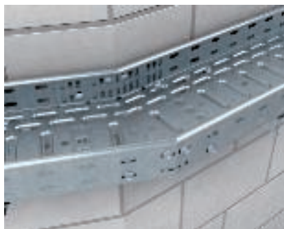
Horizontale hoekverbinding van kabelgoten Horizontale hoekverbinding van kabelgoten in/rond hoeken, met afgesneden kabelgootuiteinden.
