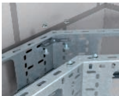
Hoekverbinding Eenvoudige vervaardiging van bochten met scharnierverbinders type SV. Hiervoor dienen de zijkanten op maat te worden gesneden.
