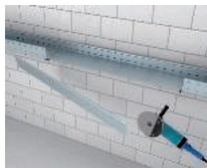
Maken van een T-aftakking met hoekaanbouwstuk Verwijderen van de zijkant uit de doorgaande verspangoot.
