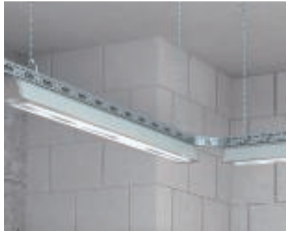
Toepassing: armatuurdraagkanaal Ophanging van een armatuurdraagprofiel met kettingen en ophangbeugels.
