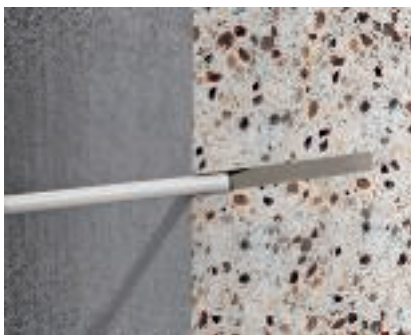
Inbrengen van de injectiemortel De injectiemortel in het gat persen.
