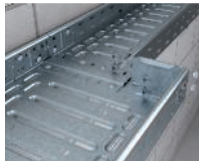
Breedteverandering en eindafsluiting Weergave van een breedteverandering door inbouw van een verloopstuk. Met dit element kan ook de eindafsluiting van kabelgoten worden gerealiseerd.
