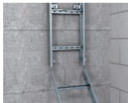
Scharnierverbinding van kabelladders Maken van een flexibele ladderhoek met scharnierverbinder type LGVG.
