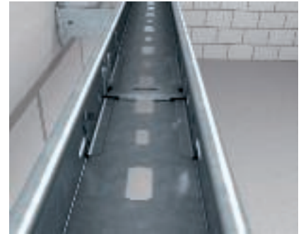
Verbinding armatuurkabelgoot Horizontale verbinding van armatuurkabelgoot type LTR met verbinderset RV 607.
