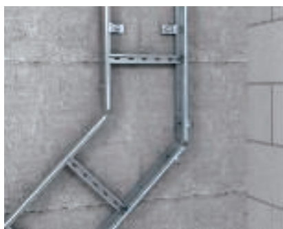
Hoekverbinding van kabelladders Maken van een flexibele ladderhoek met hoekverbinder type LWVG.
