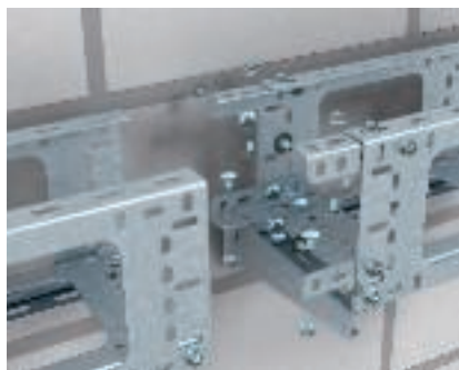
Verbinding Verbinding van BKK-kanalen met verbinders type SSV.
