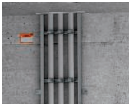
Toepassing wandmontage Wandmontage van een verticale ladder met bevestigingshoeken.
