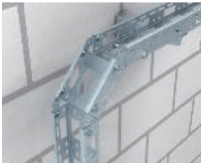
Verticale bocht 90°, dalend Montage van een dalende verticale bocht met scharnierverbinders type SV.
