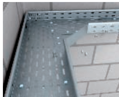
Bocht maken met hoekstuk Voor het maken van een 90°-bocht kan ter vergroting van de binnenradius het hoekstuk type REV worden gebruikt.
