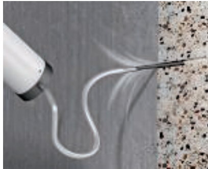
Reiniging van de boring Uitblazen van de boring voor reiniging met handblazers of perslucht.
