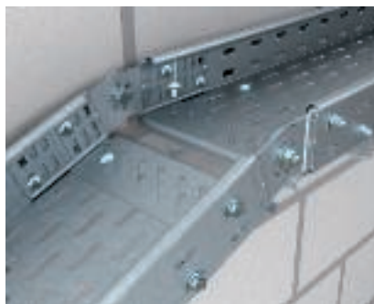
Verticale scharnierverbinding van kabelgoten Verticale scharnierverbinding van kabelgoten bij lokaal gemaakte verspringingen met willekeurige hoeken.
