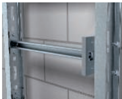
Sportbevestiging in IS 8-profiel Bevestiging van de sporthouder type SA met profielrail type MS 4022 in I-profiel
