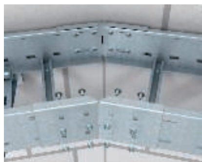
Horizontale verspanhoekverbinding Horizontale hoekverbinding van verspankabel-ladders met hoekverbinder type WRWVK.
